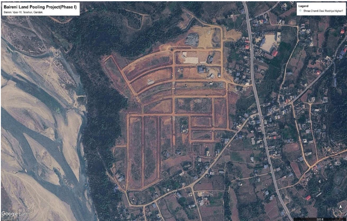
चित्र १ निर्माणाधीन प्रथम चरणको आयोजना क्षेत्रको सेटेलाइट तस्वीर (२०८२, फल्गुन)
